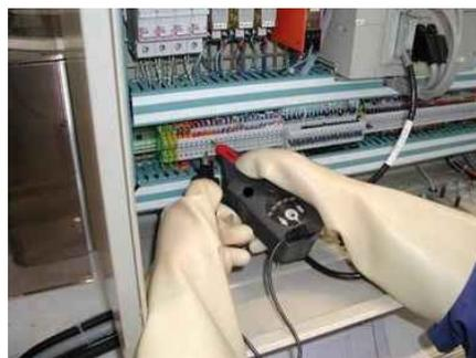
**Exemple :** Électricien devant assurer la coupure du courant dans une installation de son entreprise pour permettre le travail en sécurité de personnels d'une entreprise extérieure sur ou à proximité d'une installation dont des pièces nues sont accessibles.
