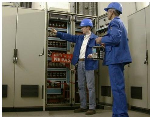
**Exemple :** Maçon effectuant une opération dans un local électrique où des pièces nues sous tension peuvent être accessibles.
